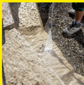
Limpeza de muros
